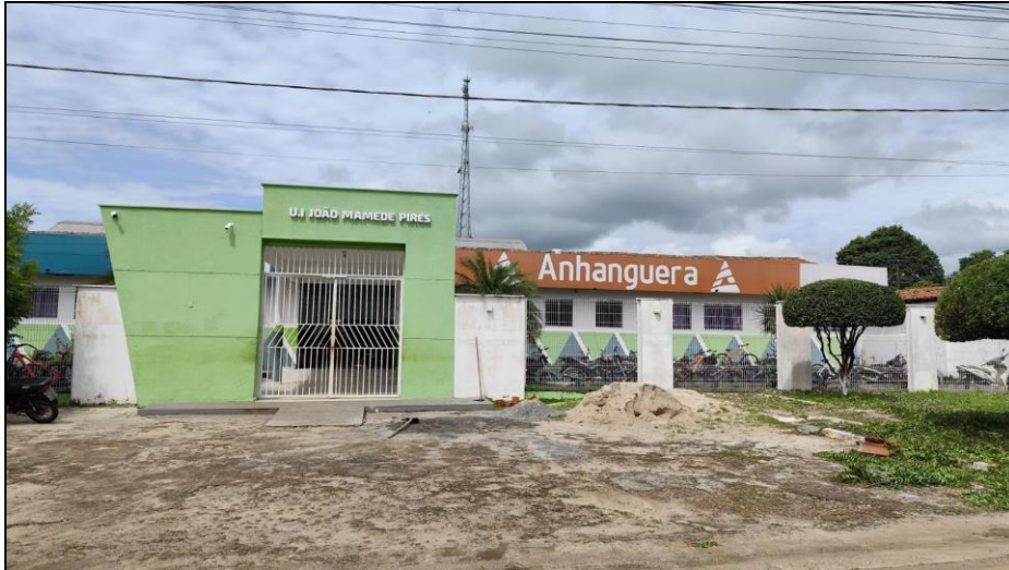
Figura 05: Fachada da Escola Unidade Integrada João Mamede Pires na Cidade de Alto Alegre do Maranhão.
