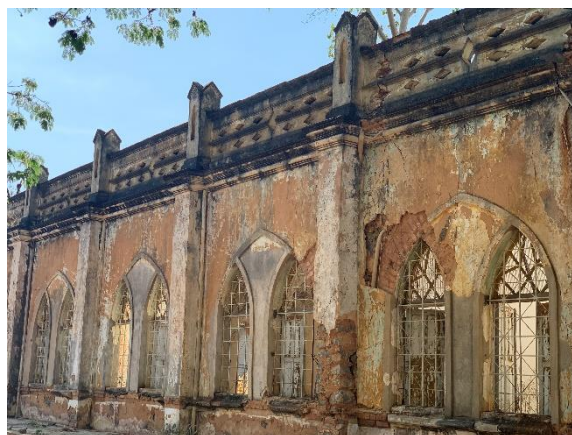
Foto 18: Prédio de 1895 (antigo abrigo)
