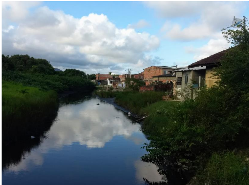
Figura 42: Assentamentos irregulares nas margens do Rio Campininha na rua Hélio Borba Vita.
