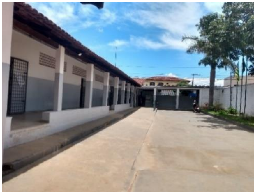
FIGURA N.º 09: Imagens da estrutura interna do Colégio Estadual José Cândido Rosa
