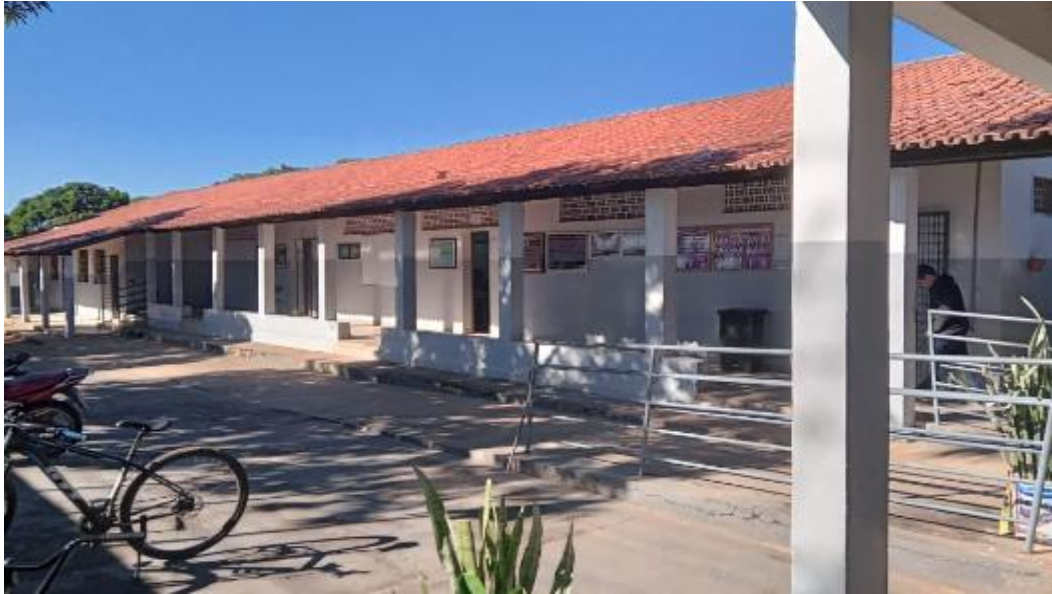
Figura 12 – Pátio do Colégio Estadual José Cândido Rosa.
