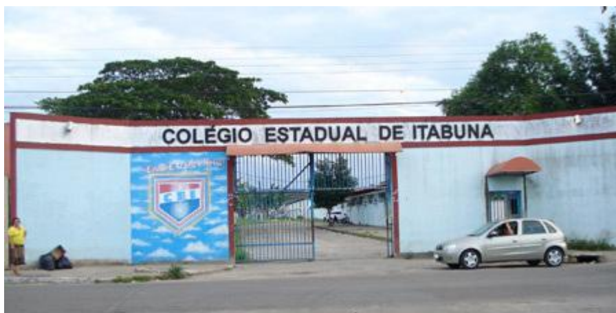
Figura nº 06: Foto da fachada da Escola
