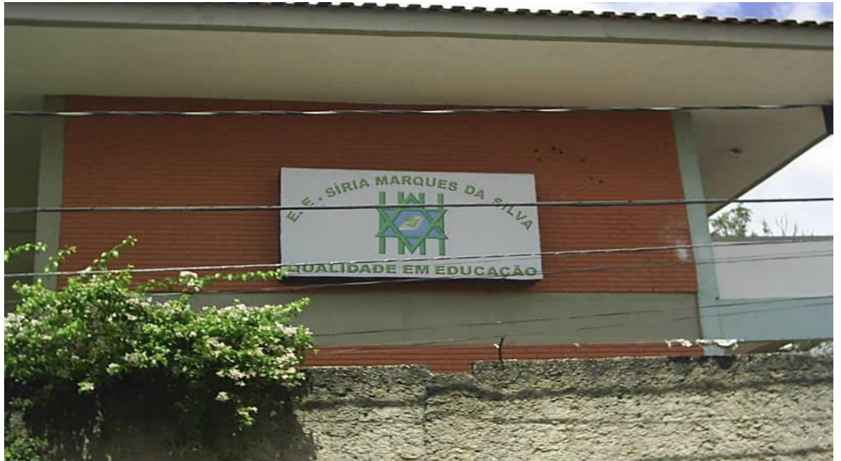
Figura 2–Foto da fachada do prédio da Escola Estadual Sírnia Marques da Silva
