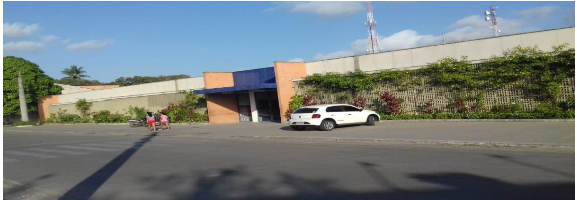
Figura 6 – Fachada da escola municipal Santa Luzia
