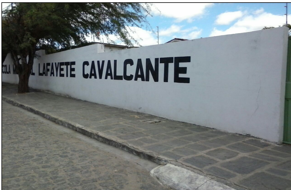
Figura 15: Faixada da Escola Municipal Lafayette Cavalcante. Fonte: elaboração própria.
