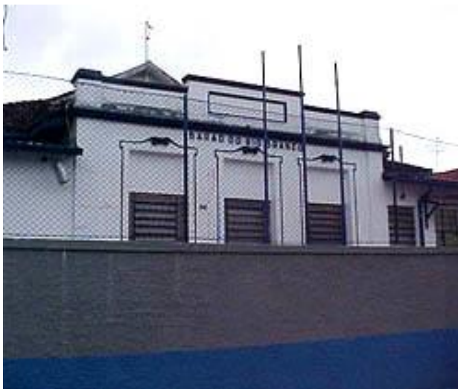
FIGURA Nº 10 – Fachada da Unidade Básica de Ensino
