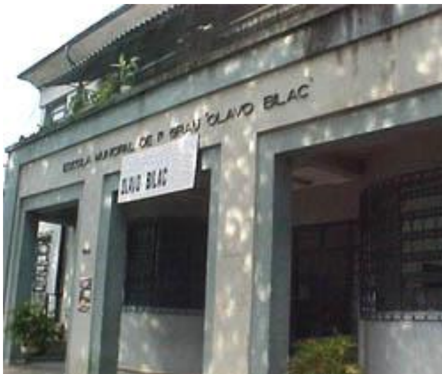
FIGURA Nº 11 – Fachada da Escola
