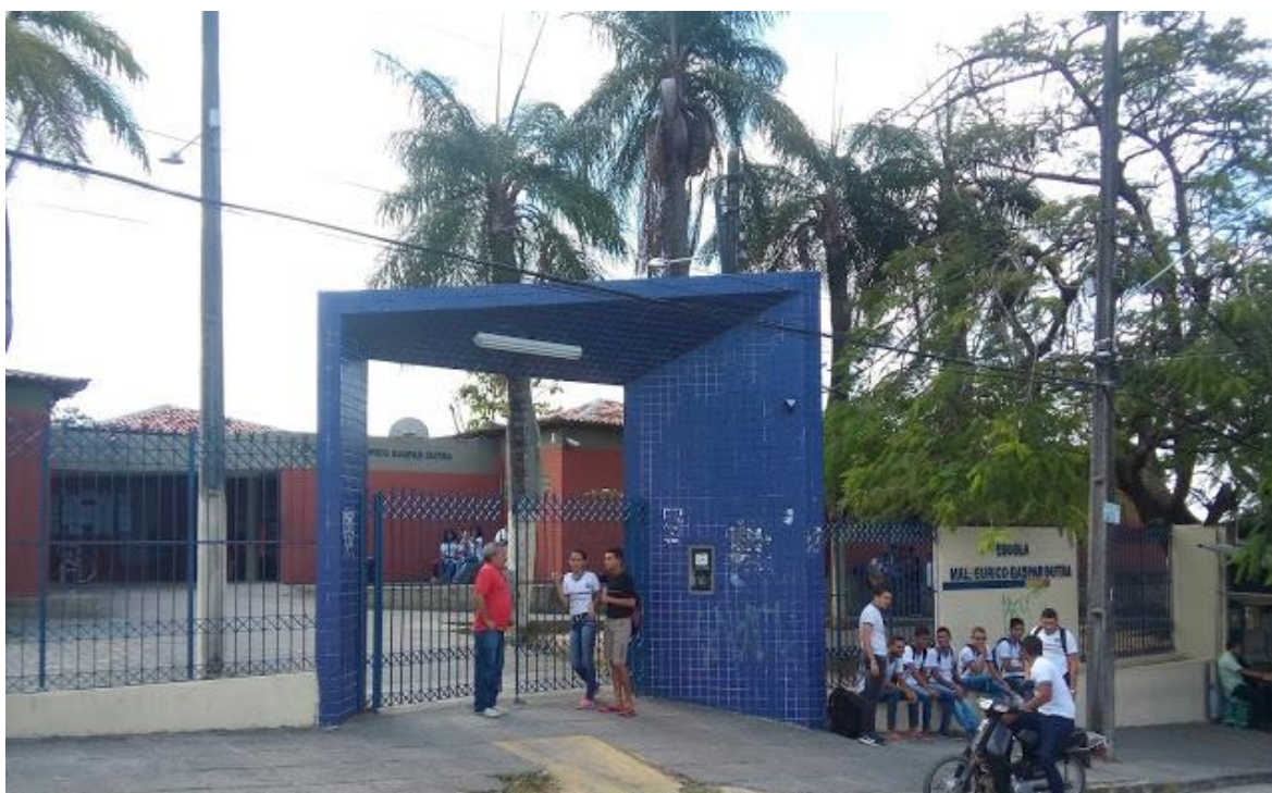
FIGURA Nº 07: Fachada da Escola Estadual Marechal Eurico Gaspar Dutra
