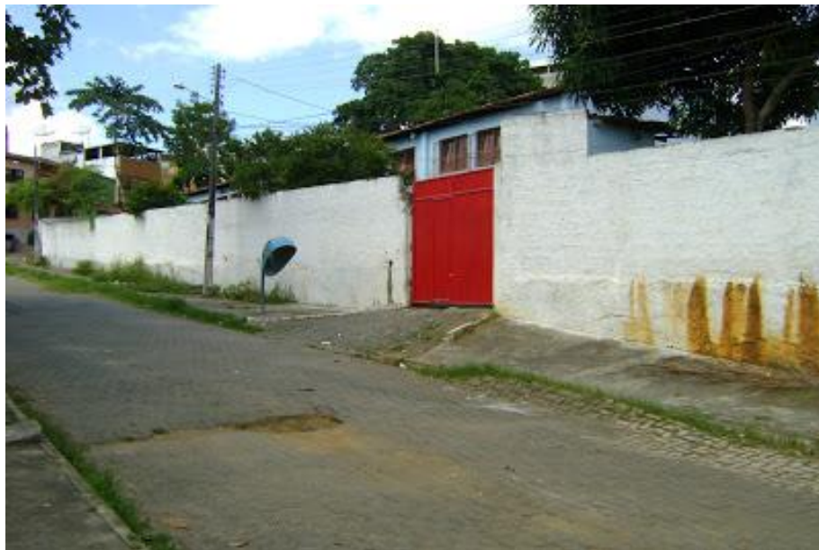
FIGURA Nº 22- Foto da fachada da escola
