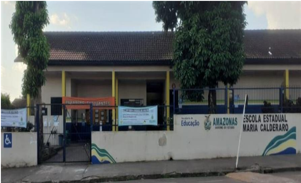
FIGURA 12: Fachada da Escola Estadual Maria Calderaro
