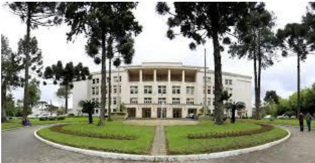
FIGURA Nº 6: Fachada do Colégio Estadual do Paraná
