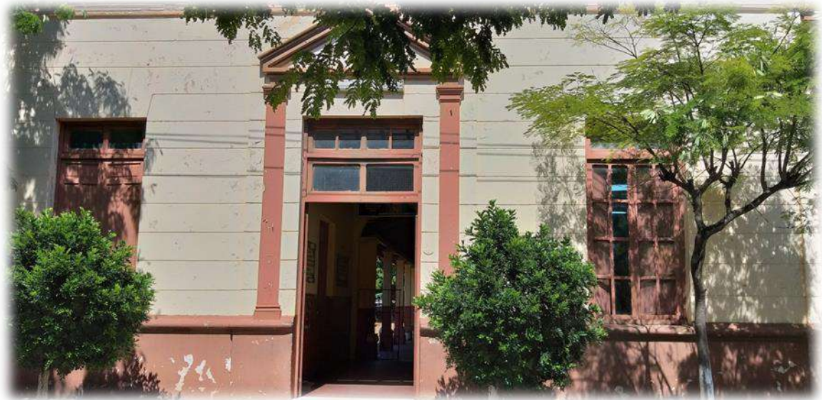
Fig. 71. Fachada de la Escuela Urbana N° 114 Ramón I. Cardozo.
